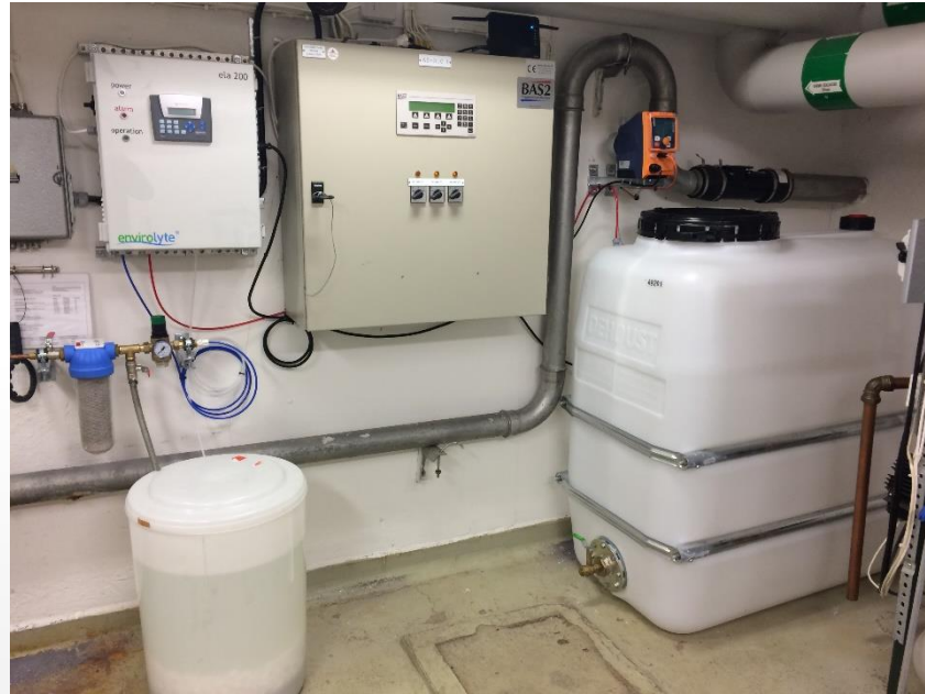
HSB-fastighet, 126 st lägenheter i Västerås
